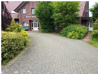
Weg vom Parkplatz zum Hoteleingang und Nebeneingang
